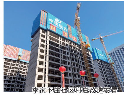
李家下庄社区村庄改造安置区建设项目封顶。璩骊儒 摄
