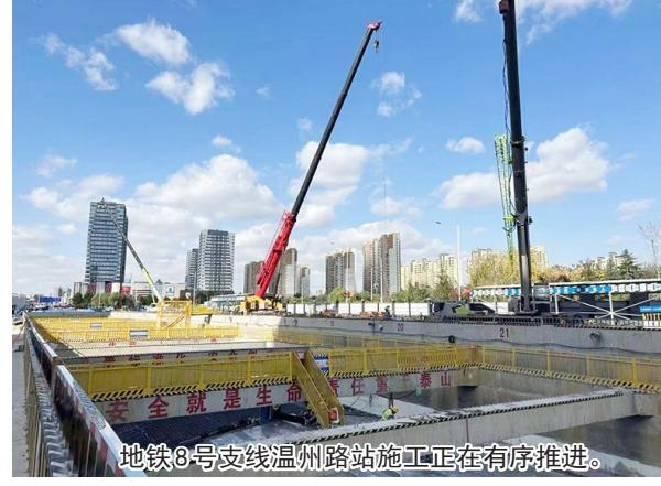
体结构墙板施工，创造了单月16块墙板浇筑记录。施工过程中，项目团队创新各类施工工艺，利用卡距尺及“异形接驳器”提升钢筋安装质量，保证了验收一次性通过，同时，不断总结技术经验，提炼了凿毛小妙招控制侧墙与底板接缝平整度及质量、主体结构圆弧底板线形控制优化等施工亮点，已被收录至地铁集团第一批质量管理经验做法，也为后续高标准施工提供了有力依据。
