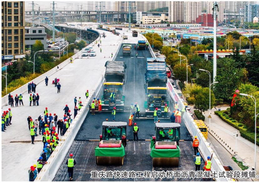
重庆路快速路工程启动桥面沥青混凝土试验段摊铺。
