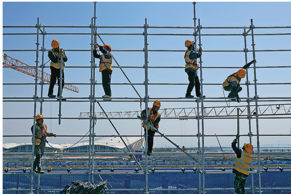
架子工正聚精会神,相互配合地搭建脚手架。
