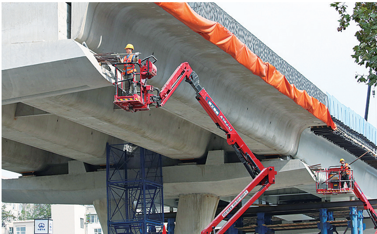
正在施工中的重庆路快速路建设项目。
