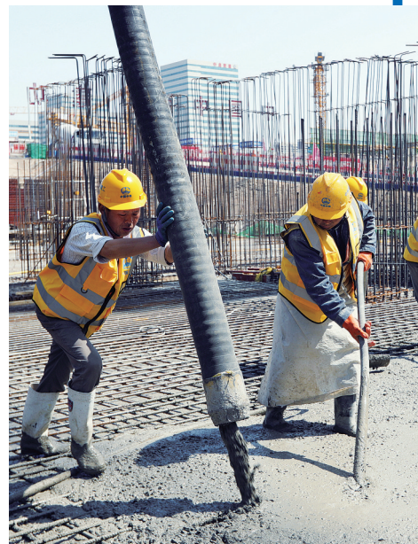
正在进行板面混凝土浇筑的工人。
