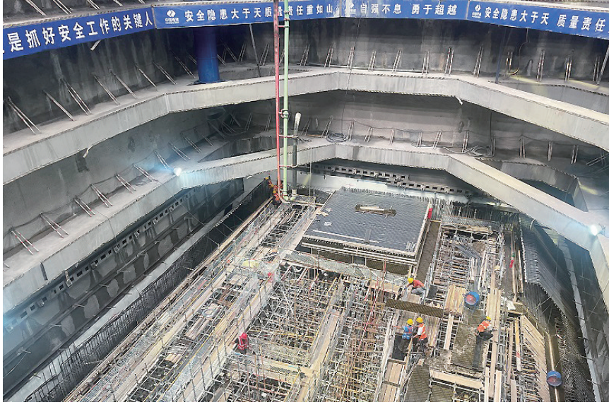
下王埠站至富锦路站区间始发井主体结构施工现场。
