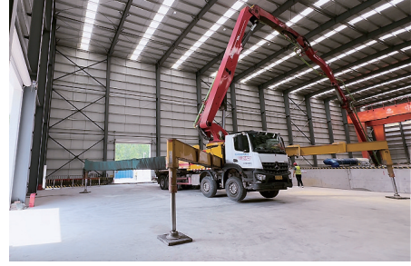
始发井主体结构封顶施工现场 泵车正在浇筑混凝土。
