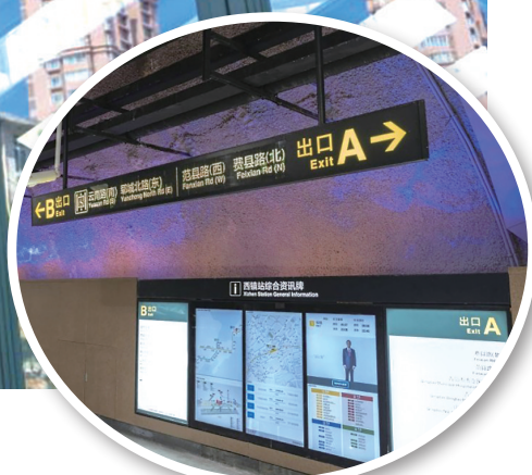
地铁 1 号线西鎮站 A 出入口。
