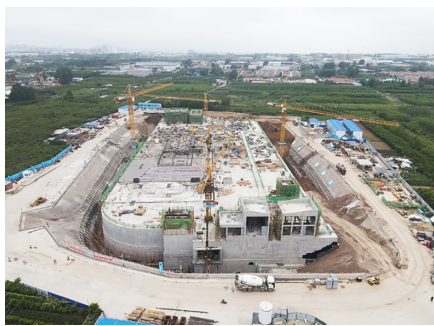
航拍即墨首座地下污水处理厂建设现场。
