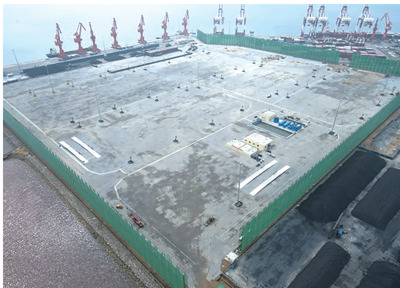
董家口港区大唐码头二期工程(后方堆场)通过竣工验收。
