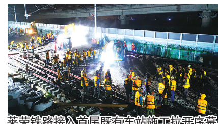
莱荣铁路接入首尾既有车站施工拉开序幕。
