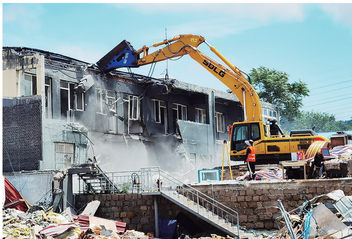
5月31日的拆除现场。刘卓毅 摄
