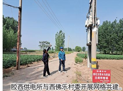
荷情况，对西佛乐村原100kVA最大负载率83%的公用变压器进行了改造，新增200kVA公用变压器一台，低压线路改造65米，协调完成供电设备改造提升，保障了当地农业灌溉的用电需求，并得到了村委和村民的一致认可。
