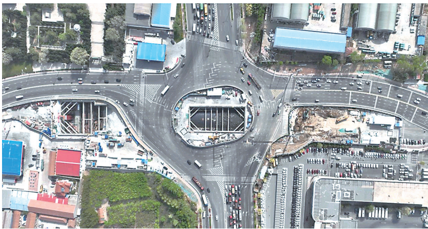
地铁7号线青威路施工调流图(航拍)。
