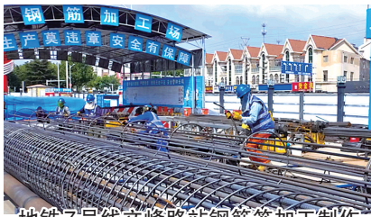
地铁7号线文峰路站钢筋笼加工制作。
