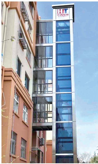
城阳仁和居小区西区加装的首套电梯已顺利竣工。
