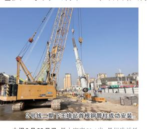
本报3月23日讯 最大宽度53.6米,是标准地铁 站的2倍以上;主体结构采用"明盖结合和半幅盖挖顺 做法",分两期进行施工-一青岛地铁2号线二期下王 埠站在建设过程中"一个顶俩",施工难度之大不言而 喻。记者23日从地铁集团获悉,车站首根钢管柱近日 成功安装,为后续主体结构施工奠定了基础。
