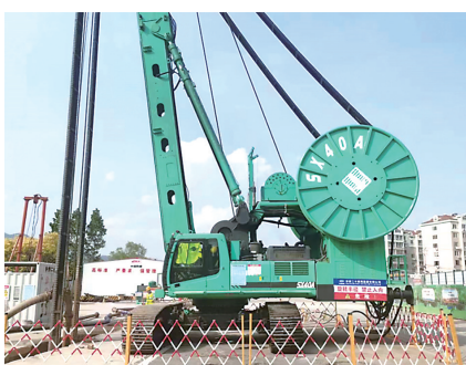
主体附属围护结构施工机械双轮洗设备。
