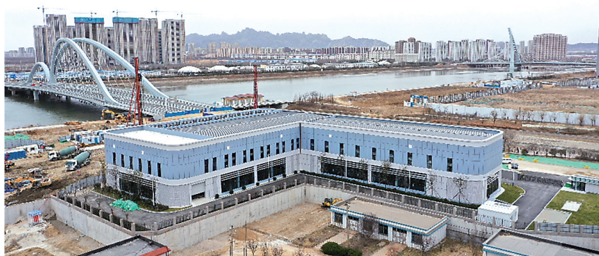
青岛西海岸新区华能董家口电厂至新区西部城区长输供热管线项目。
