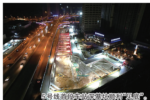
5号线首段车站深基坑顺利“见底”。
