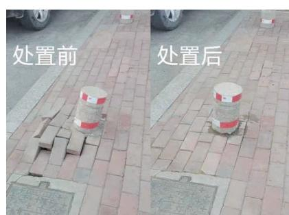
整修,“工人到场后对鼓包路面进行了修补,同时加固了挡车柱,消除安全隐患,当天就处理好了。”
