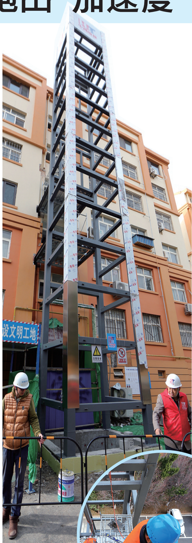
▲ 加装电梯 现场井然有序。
