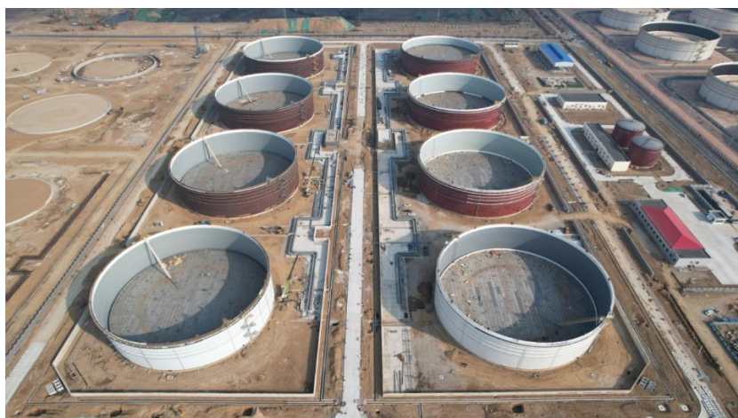
董家口港区 振华原油库工程 项目。
