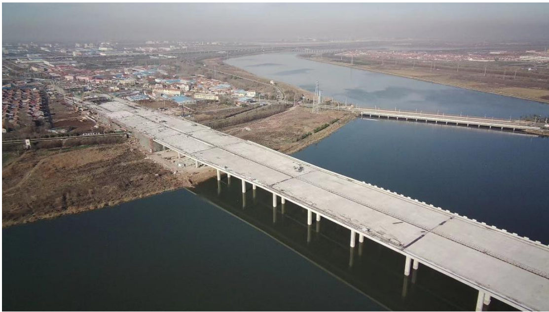
国道204大沽河桥梁项目。
