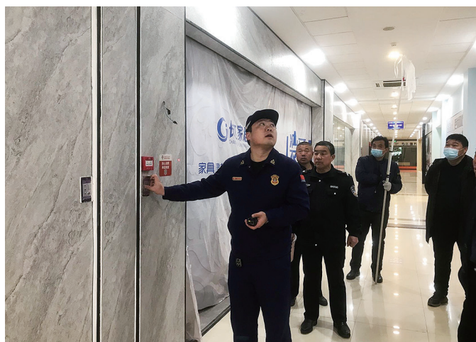
防火监督人员正在测试一家企业内部的防火设施。
