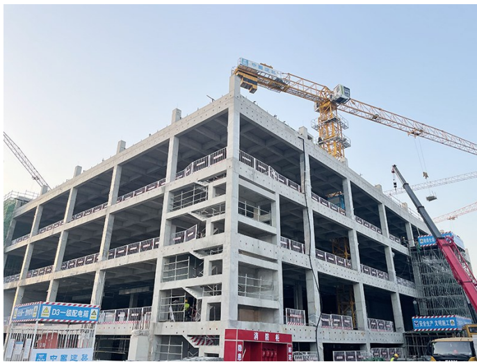
青岛虚拟现实产业园项目全力冲刺保交付。
