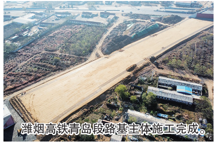
潍烟高铁青岛段路基主体施工完成。
