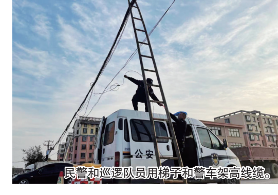
民警和巡逻队员用梯子和警车架高线缆。
