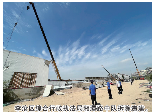
李沧区综合行政执法局湘潭路中队拆除违建。
