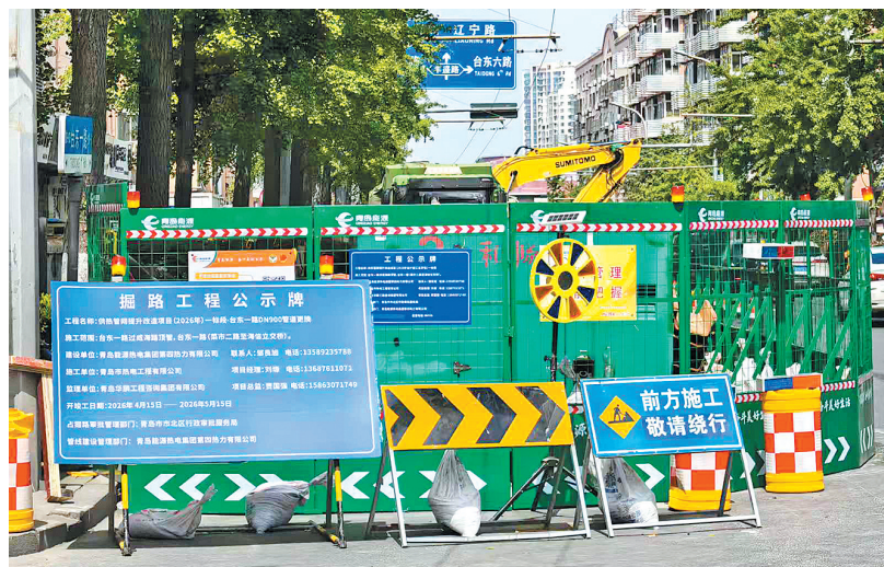
■市北区台东一路（辽宁路—海信立交桥段）供热管网改造项目施工现场。王冰洁 摄
