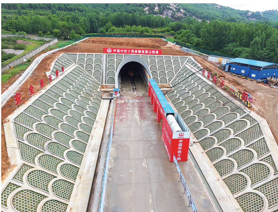
■报屋山隧道提前完成贯通目标。
