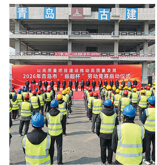
■3月20日，2026年青岛市“以高质量项目建设推动高质量发展”“振超杯”劳动竞赛启动仪式。今年，青岛市各级工会将组织开展各类劳动和技能竞赛3000余项，计划发动职工群众150余万人次参赛，持续锻造一流产业工人队伍，促进重大战略、重大工程、重大项目落地，服务经济社会高质量发展。
