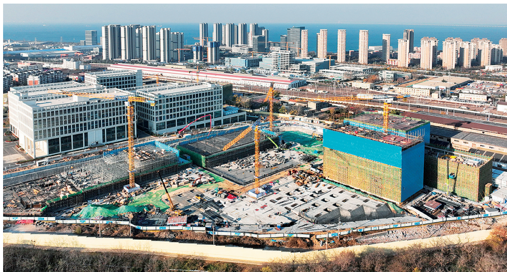
■全域布局的“中国康湾”战略中，生命健康科技高端智造产业基地（二期）等项目将撑起千亿级生命健康产业链。图为项目施工现场。 本报资料照片
