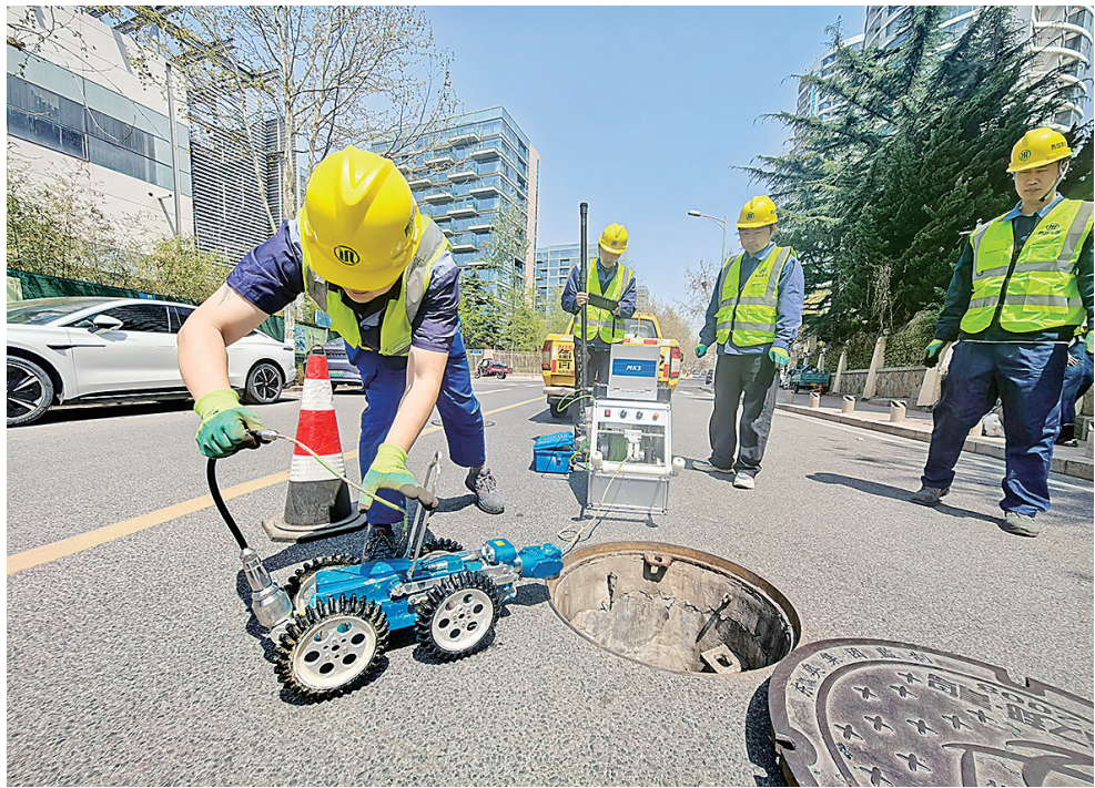
■青岛水务排水公司工作人员准备将管道机器人放入检查井。吴帅 摄
