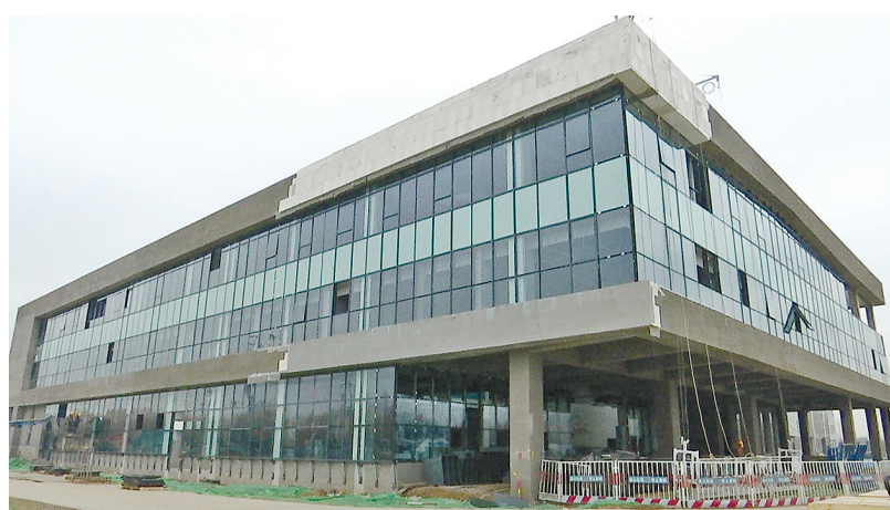
■庞仕国际海洋深蓝产业基地项目施工现场。
