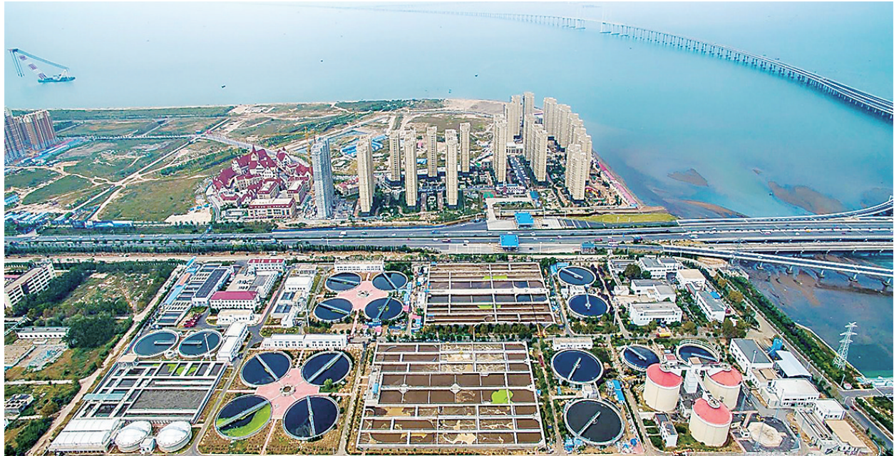
■李村河污水处理厂俯拍图。
