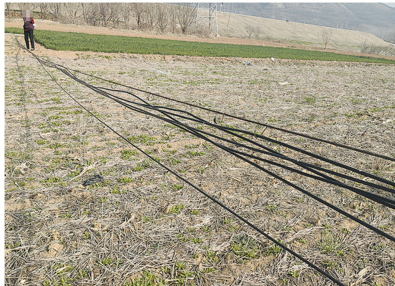
■在沙沟东村农田里,一根线杆倒塌,线缆垂地。
