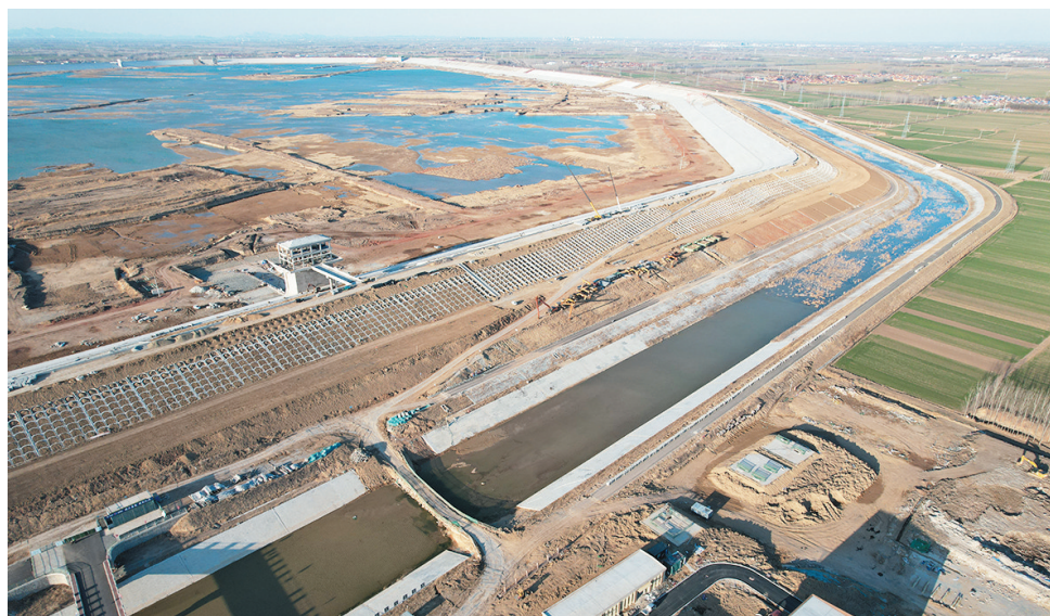
俯瞰建设中的官路水库大坝。
