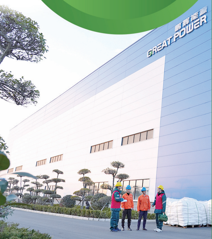
■鹏辉能源储能电池项目已投产运行。
