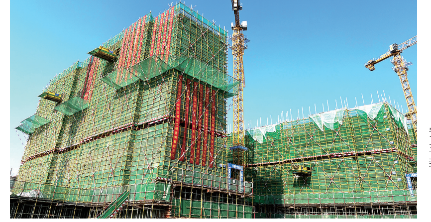
长润社区安置区项目楼座主体结构已整体封顶。
