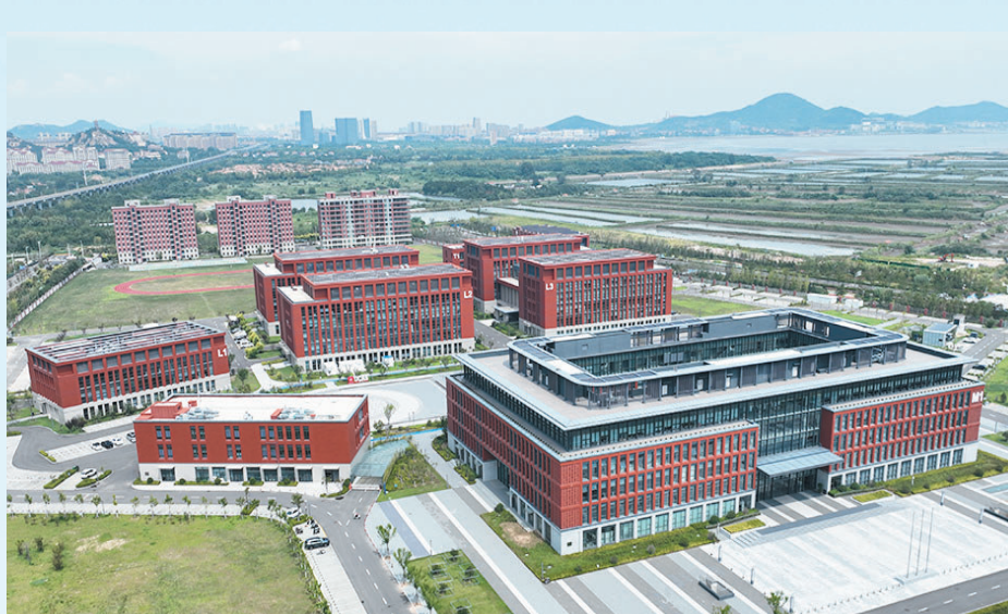
航拍中科院青岛能源所。韩星 摄
