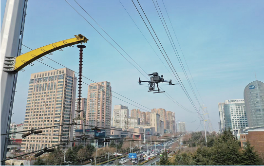
■国网青岛供电公司工作人员在220千伏李南线进行无人机巡检。
