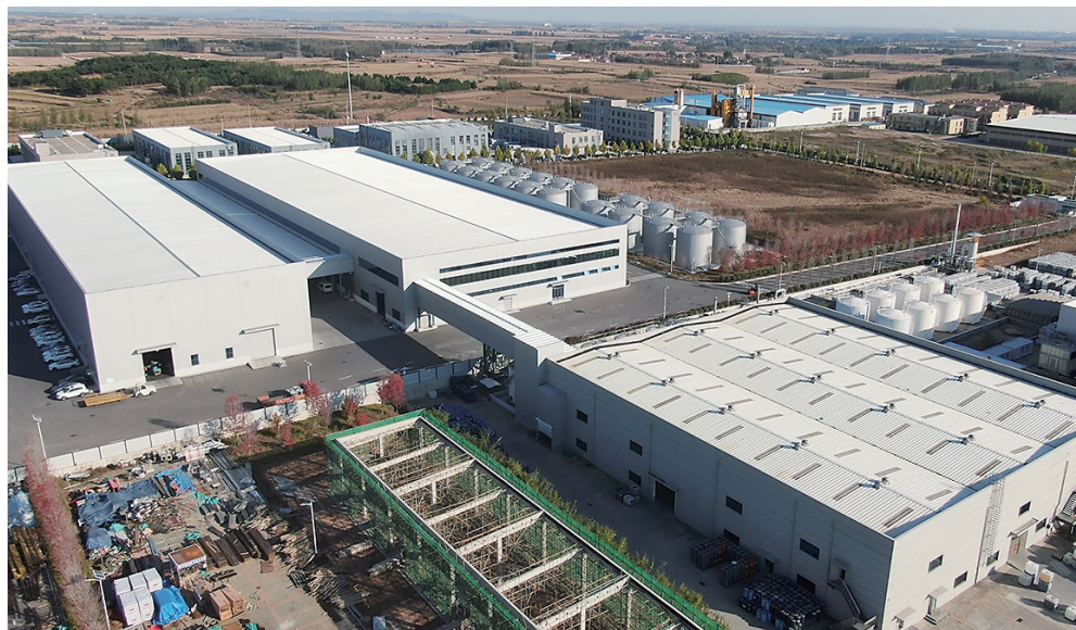
■中科润美高端润滑材料建设项目一期已竣工投产，二期正在加紧主体施工。
