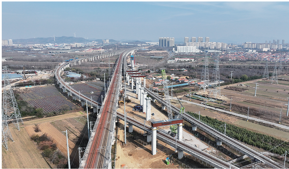
■潍宿高铁至青岛连接线项目全线首个上跨既有有线钢横梁吊装完成。
