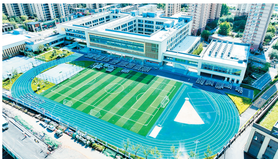
青岛连续八年将学校建设列入市办实事,一批新校园、新设施的启用为教育事业高质量发展注入新活力。图为今年9月正式启用的青岛六十三中北校区。 韩星摄
