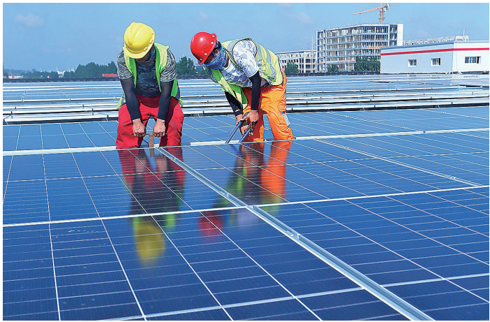
■技术人员在即发工业园调试厂房屋顶的光伏发电板。 梁孝鹏 摄
