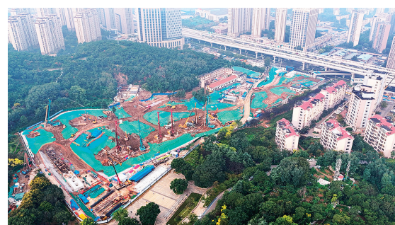
双山隧道施工现场，大型设备林立，机械轰鸣。王冰洁 摄
