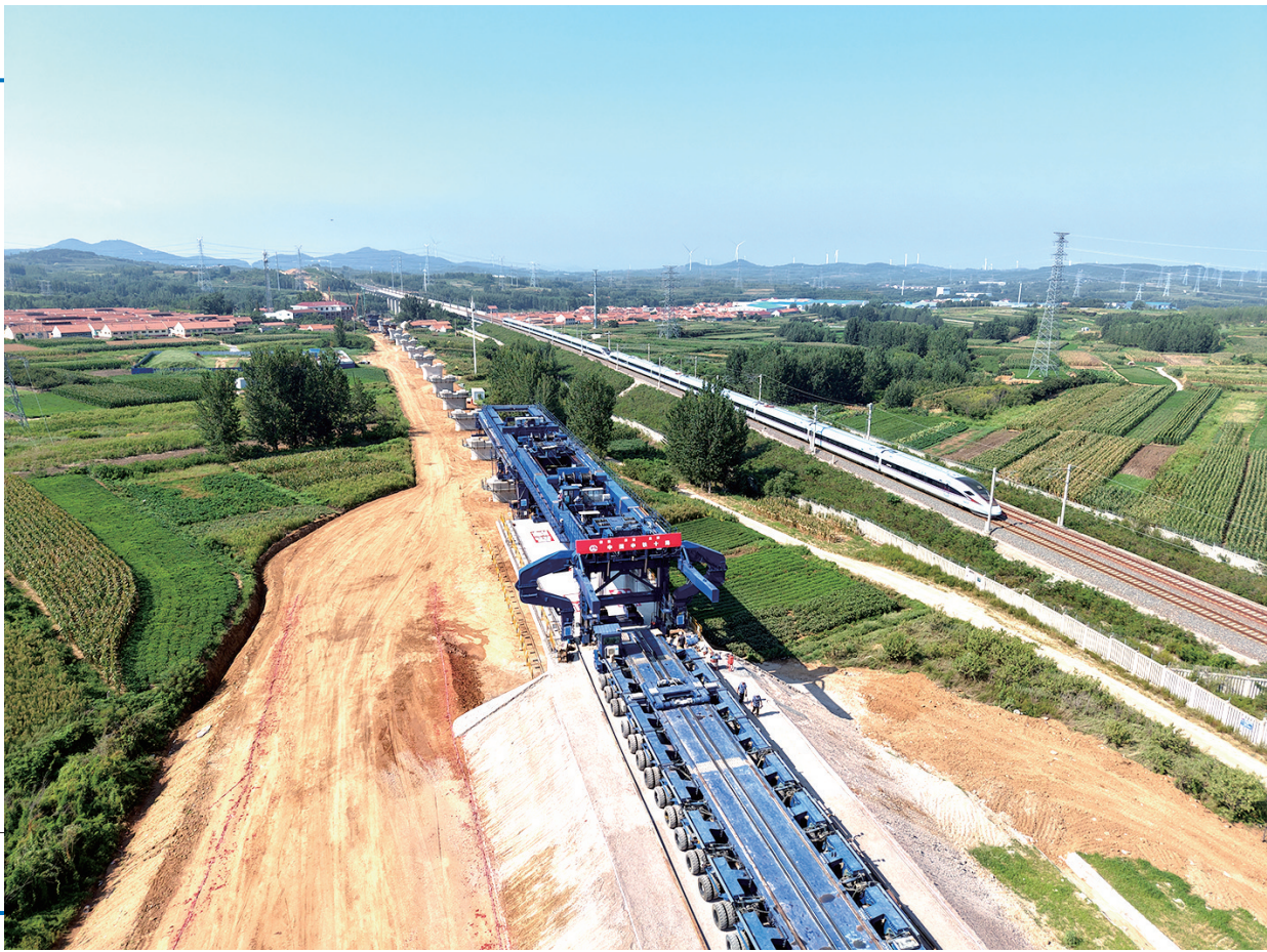
■图为潍宿高铁至青岛连接线1标段开始架设首榀箱梁。
