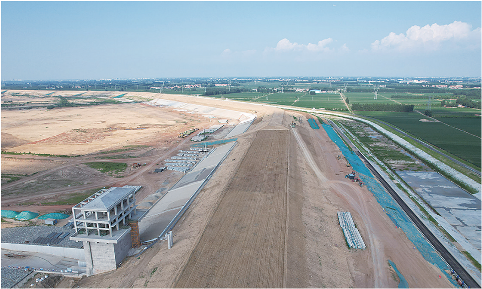
■官路水库大坝护砌工程施工现场。吴 帅 摄
