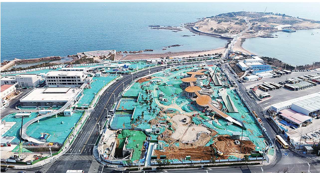
■麦岛停车场试运营,地面景观正紧锣密鼓地施工。
