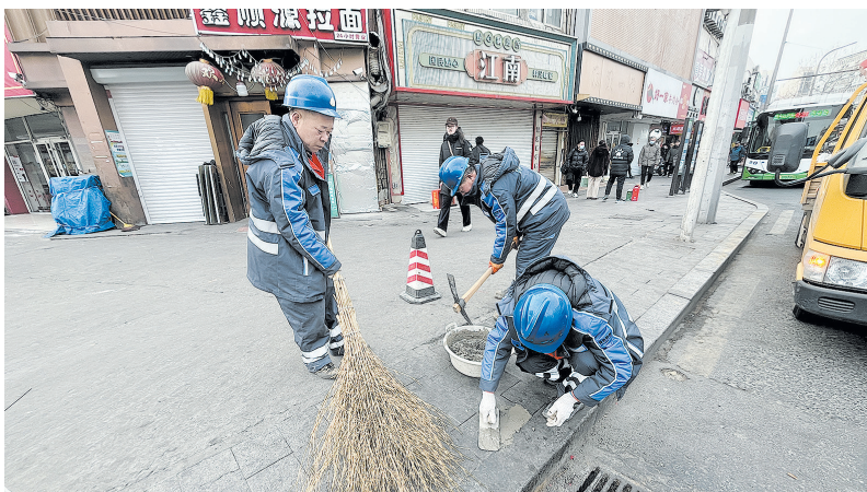
■青岛聚泰集团市政作业队伍修整破损路面。 郝明轩 摄
