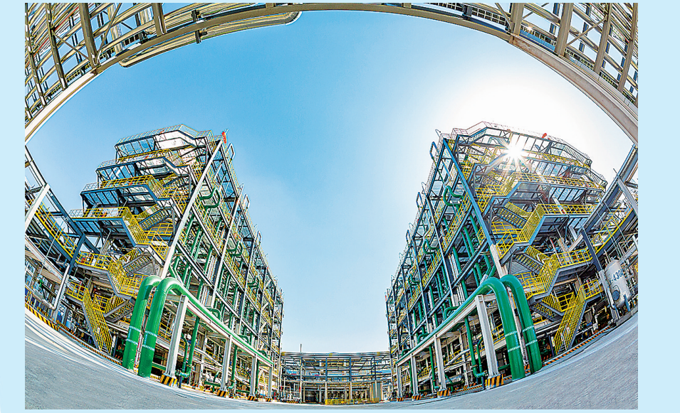
■青岛海湾集团董家口产业园区乙炔法聚氯乙烯装置。
