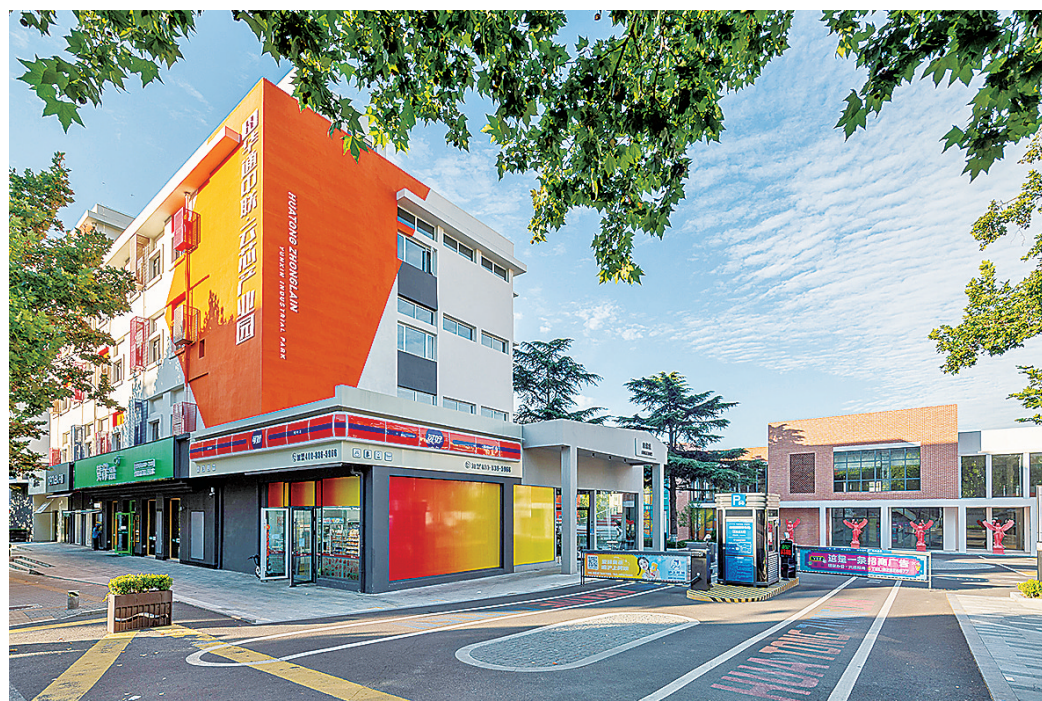
■位于延安三路109号的华通·中联云芯产业园(原海珊制衣厂)。
