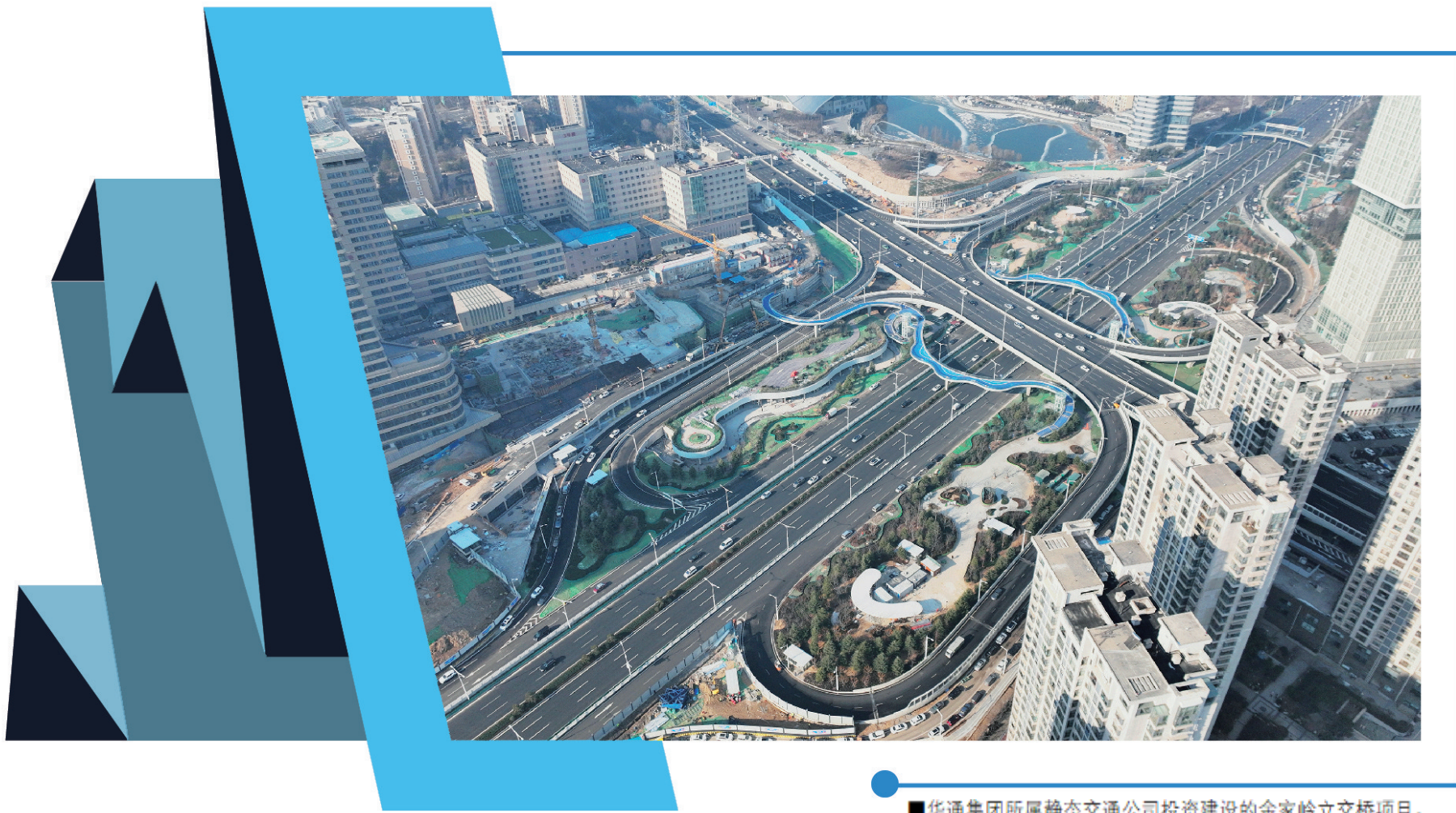
■华通集团所属静态交通公司投资建设的全家岭立交桥项目。
