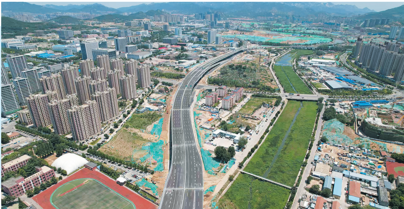
■跨海大桥高架路二期。
