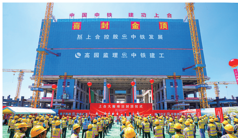
■中铁发展投资建设的上合国际会议中心项目顺利封顶。
