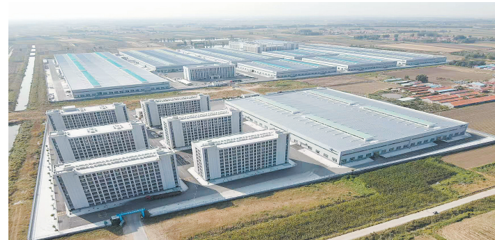
■东橡科技新材料项目打造全球高强度输送带生产基地。
