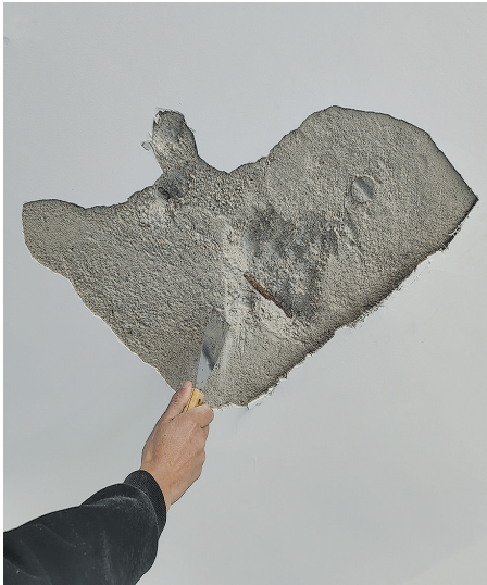
■王先生用铲刀敲击天花板,砂土随即掉落。
