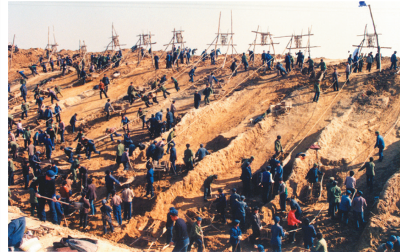
■引黄济青暗渠开挖场景。资料照片
