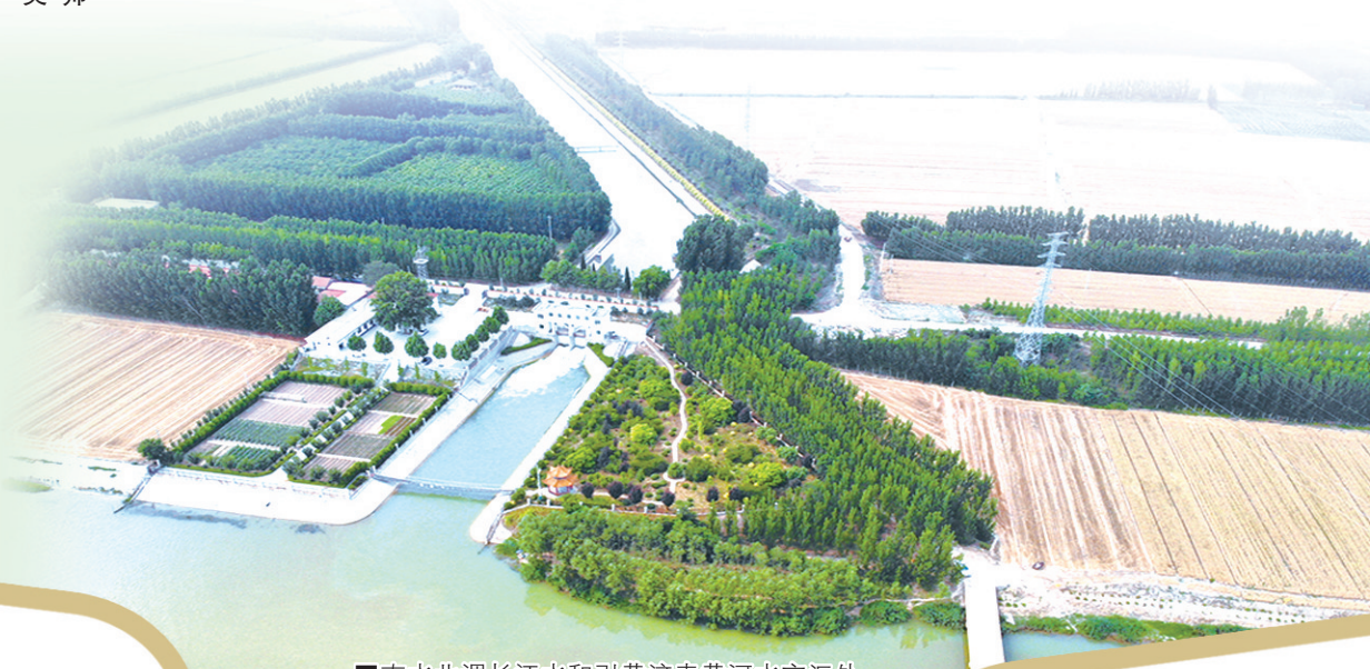
■南水北调长江水和引黄济青黄河水交汇处。梁超 摄(拍摄于2019年6月12日)
